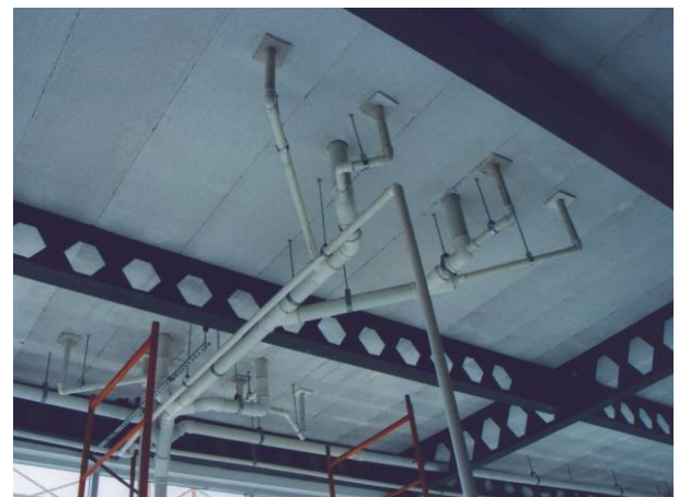
Fig. 20: Instalaciones sanitarias en nivel inferior de losa.
