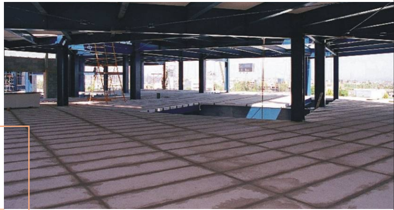
Fig. 25: Juntas entre paneles coladas y afinadas.
