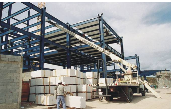
Fig. 2: Almacenamiento de panel Hebel en obra.
