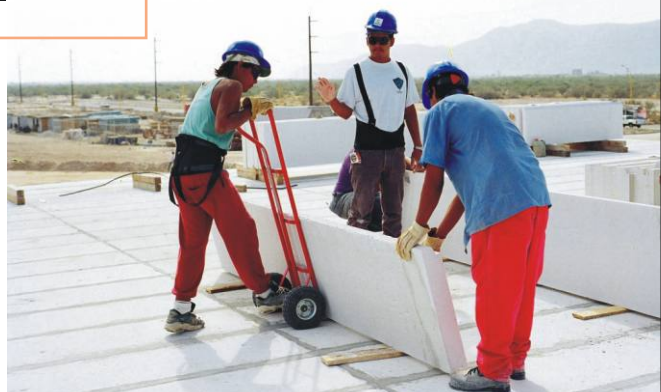
Fig. 5: Colocación del panel sobre el "diablito".
