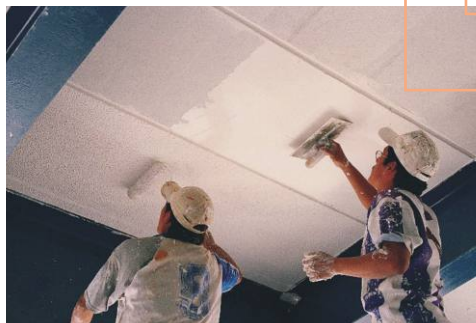
Fig. 23: Pasta acrílica en acabado inferior de panel Hebel
