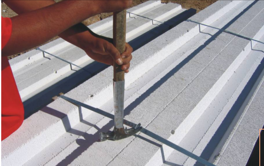
Fig. 4: Desflejado de paquetes de paneles.
