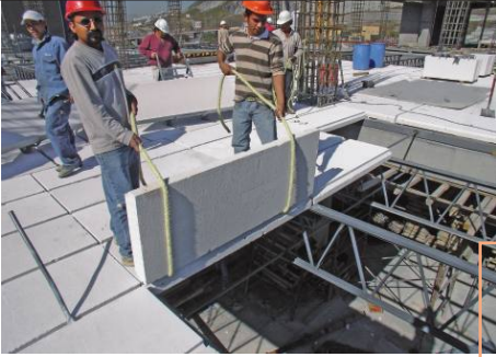
Fig. 7: Acercar el panel a su posición final en la losa.
