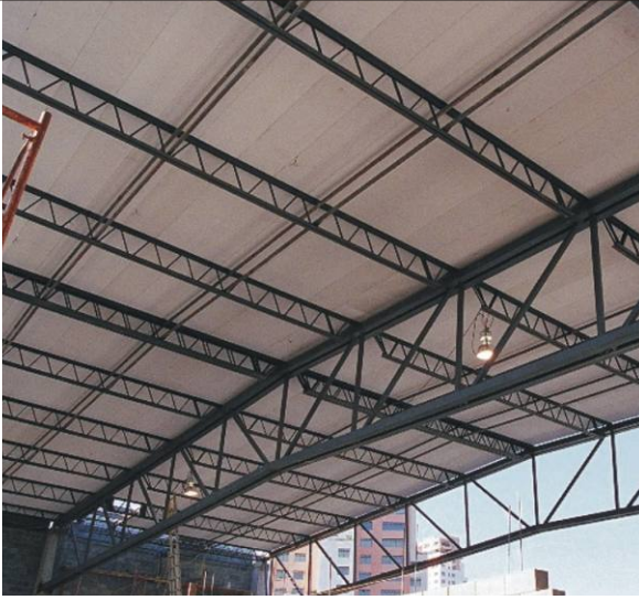
Fig. 13: Panel de cubierta sobre apoyos tipo Joist.
