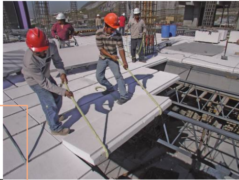
Fig. 9: Volteo del panel con cuerdas (notese la posición del panel para facilitar la instalación).
