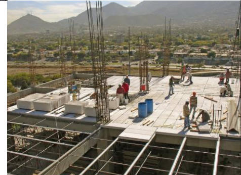
Fig. 10: Revisar la alineación de los paneles y tableros.
