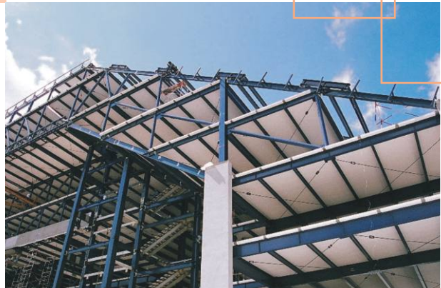
Fig. 27: Vista inferior de panel de entresí.
