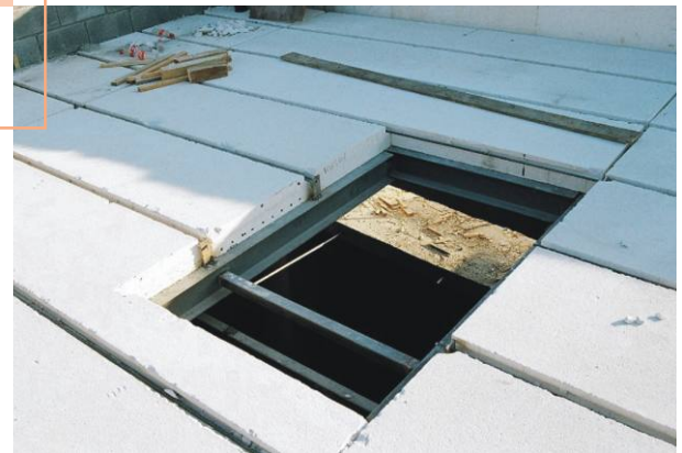
Fig. 19: Hueco en losa para domos o instalaciones.
