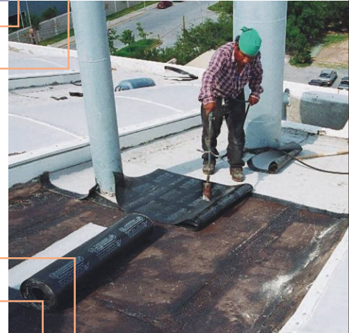
Fig. 22: Impermeabilización de membrana.
