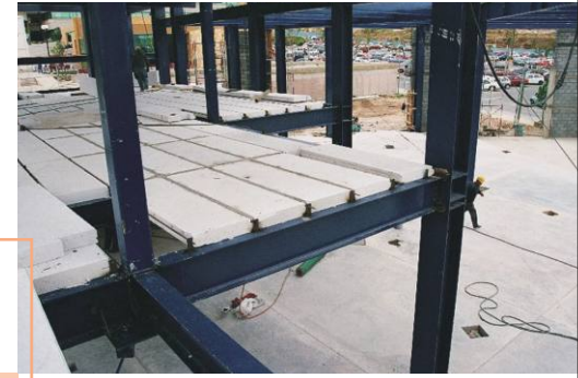
Fig. 14: Panel de entresuelo sobre apoyos tipo IPR.
