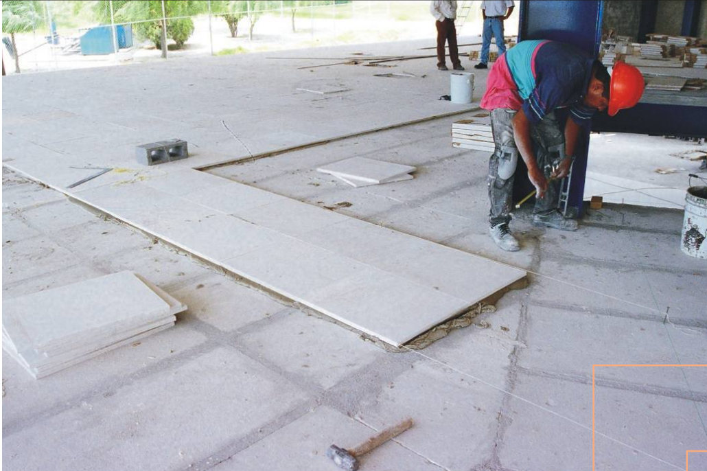
Fig. 21: Colocación directa de piso sobre panel Hebel.
