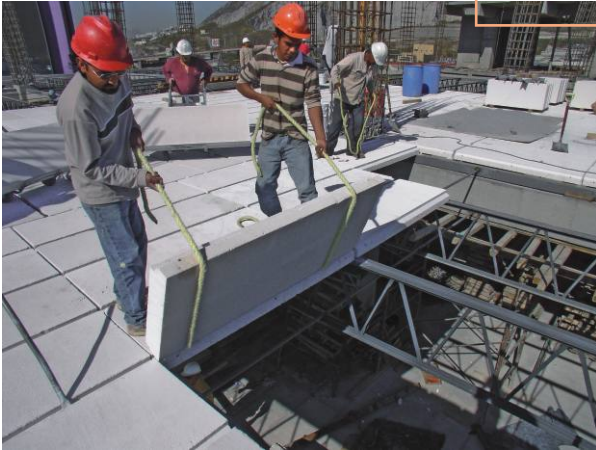
Fig. 8: Una vez colocado el panel se retiran las cuerdas y se empuja a tope con el anterior.
